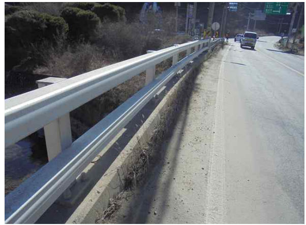
난간 및 연석 전경
