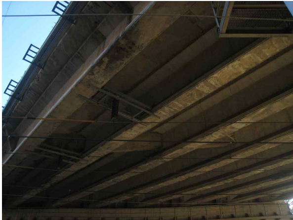
거더 및 바닥판하면 전경
